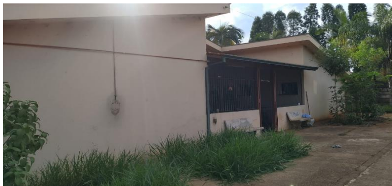
Figura 62: Fotografia da entrada das moradias 03/04 do bloco 02
