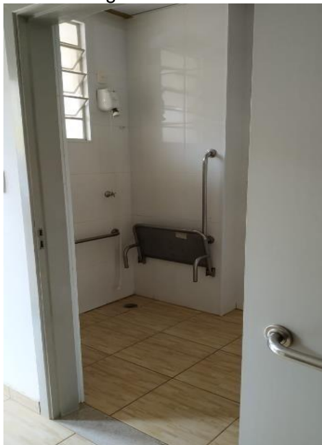
Figura 80: Fotografia do banheiro suíte do dormitório PNE
