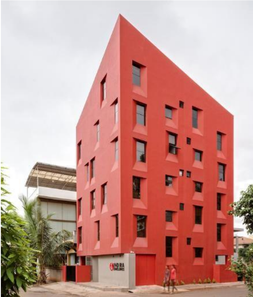
Figura 17: Foto da fachada principal
