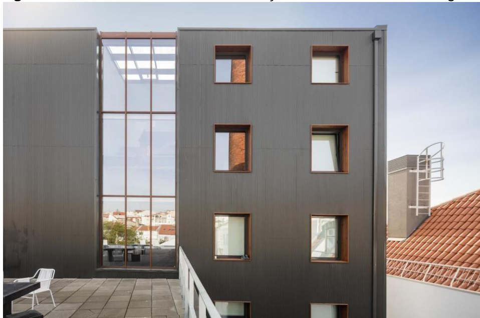
Figura 18: Foto fachada fundo da Habitação Doorm / Lisboa – Portugal
