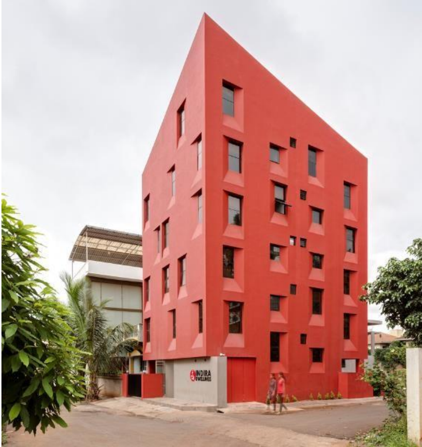
Figura 5: Fotografia do edifício Indira Dwellings
