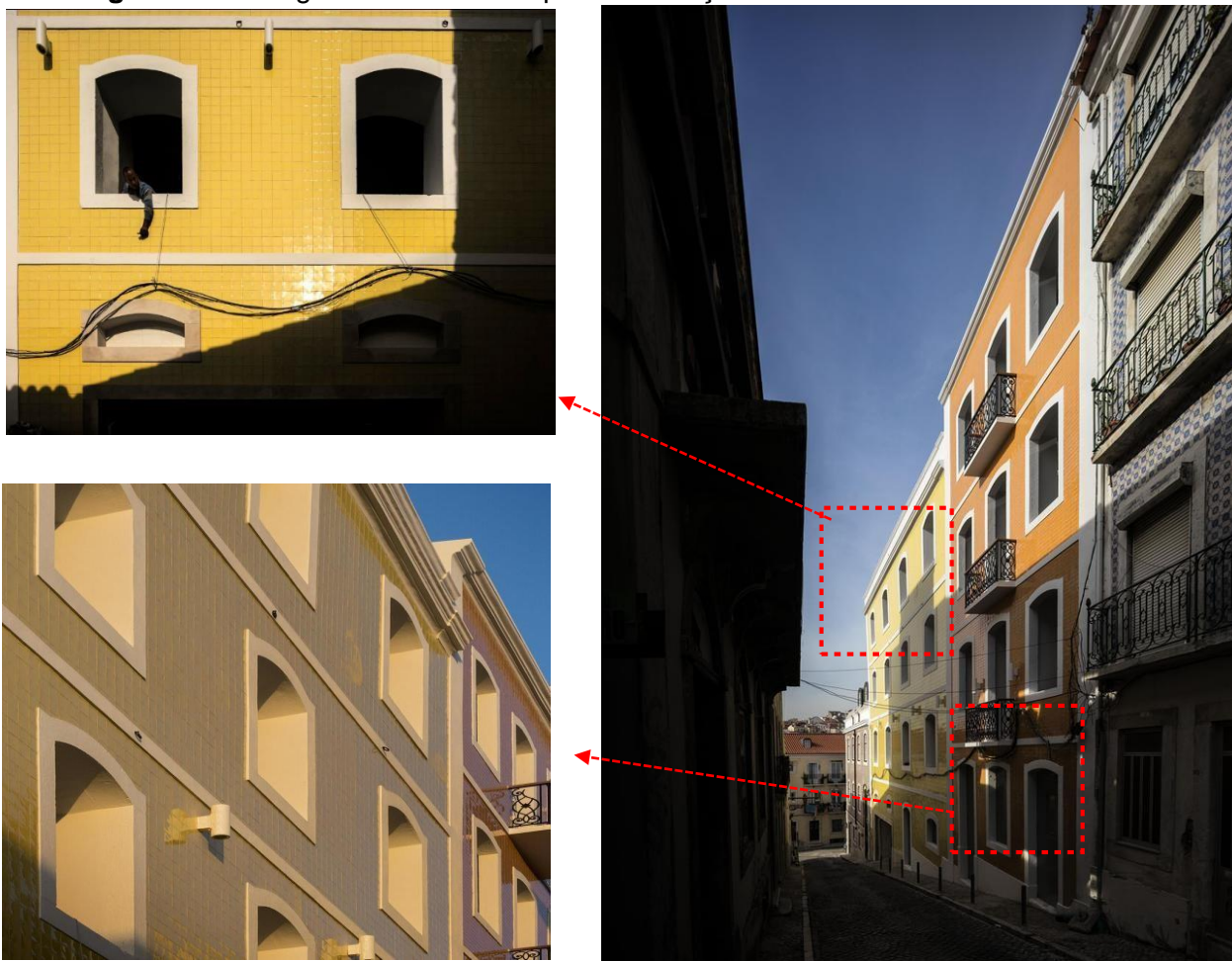
Figura 24 : Fotografia da fachada após intervenção
