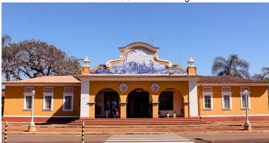
Figura 66: Fotografia da fachada frontal, prédio principal do campus “Fernando Costa” - FZEA / USP Pirassununga.
