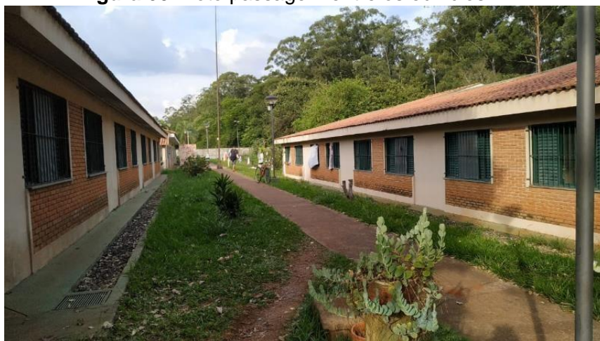
Figura 60: Foto passagem entre os edifícios
