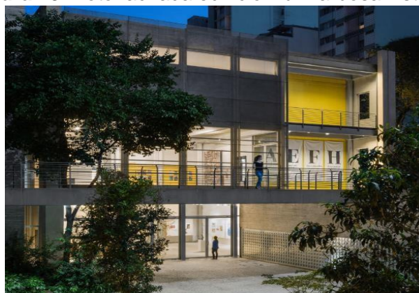
Figura 45: Foto fachada edifício Rui Barbosa vista do pátio arborizado
