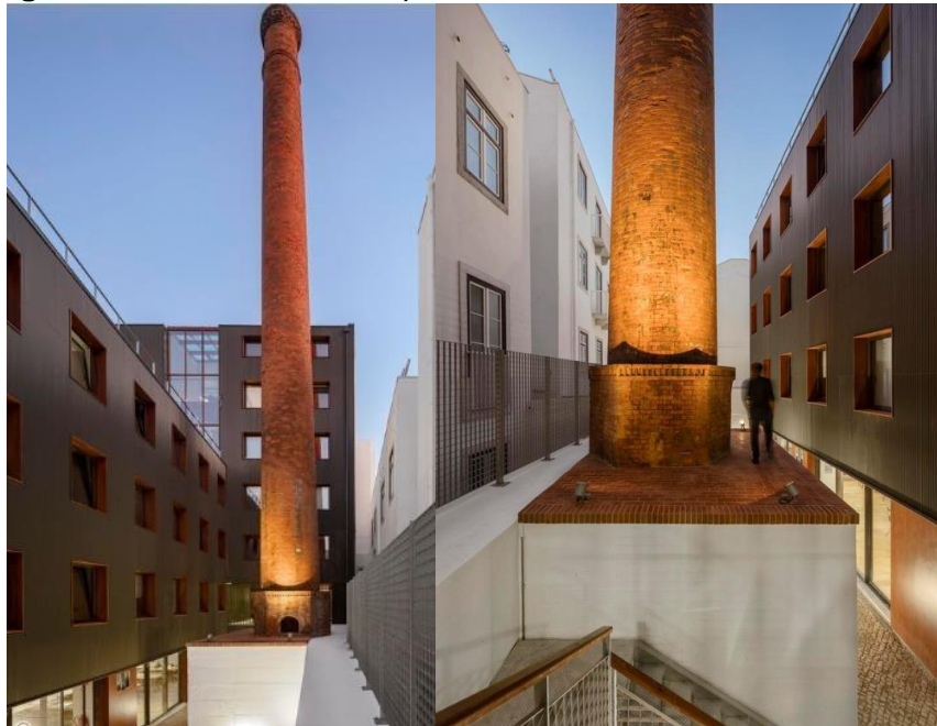
Figura 35: Foto chaminé da pré - existência
