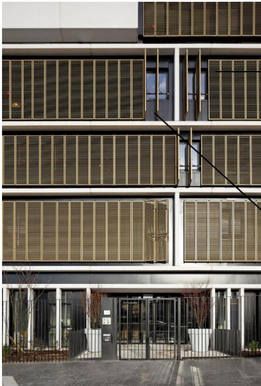
O elemento vazado da fachada é de madeira emoldurada em metal enquanto que os pilares, vigas e lajes são de concreto. A estrutura de concreto de vigas e pilares em toda a construção permitem um certo grau de flexibilidade, é porque a vedação é independente da estrutura
