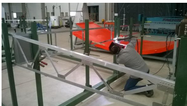
Figura 31: Reparo de solda em estrutura de gabarito
