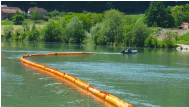
Figura 17: Aplicação da barreira
