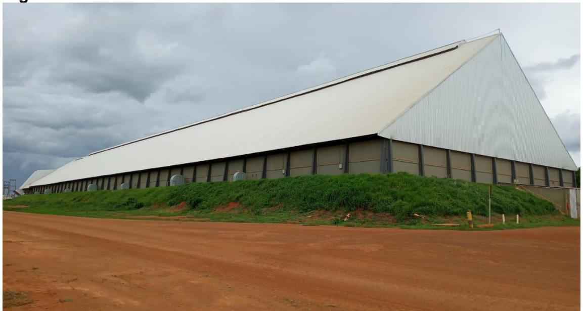
Figura 6 – Armazém 3 da Unidade Carazinho
