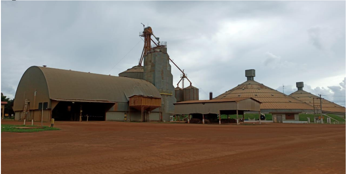
Figura 5 – Armazém 2 da Unidade Carazinho
