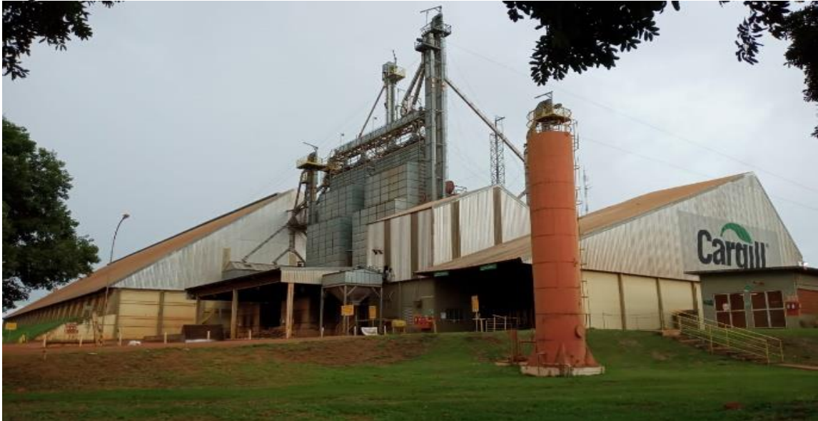
Figura 4 – Armazém 1 da Unidade Carazinho
